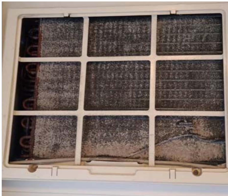
ภาพที่ 32 สภาพเครื่องปรับอากาศก่อนทำความสะอาด
