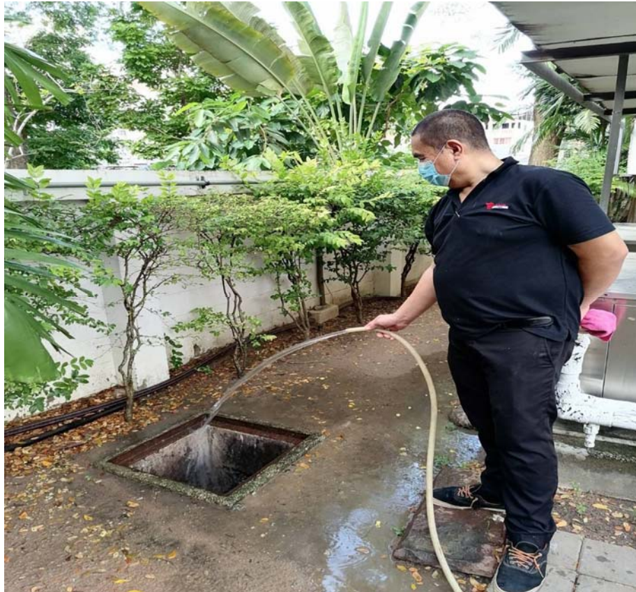
ภาพที่ 35 เจ้าหน้าที่ล้างทำความสะอาดถึงเก็บน้ำใช้แต่ละอาคาร
