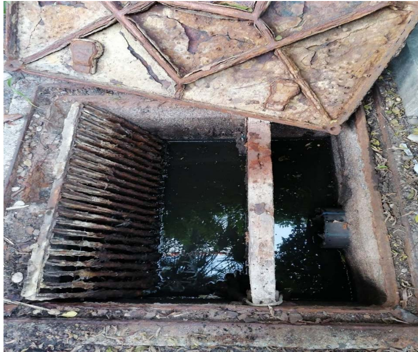
ภาพที่ 21 แสดงบ่อน้ำบาดน้ำเสียที่ติดตั้งตะแกรงคัดมูลฝอย
